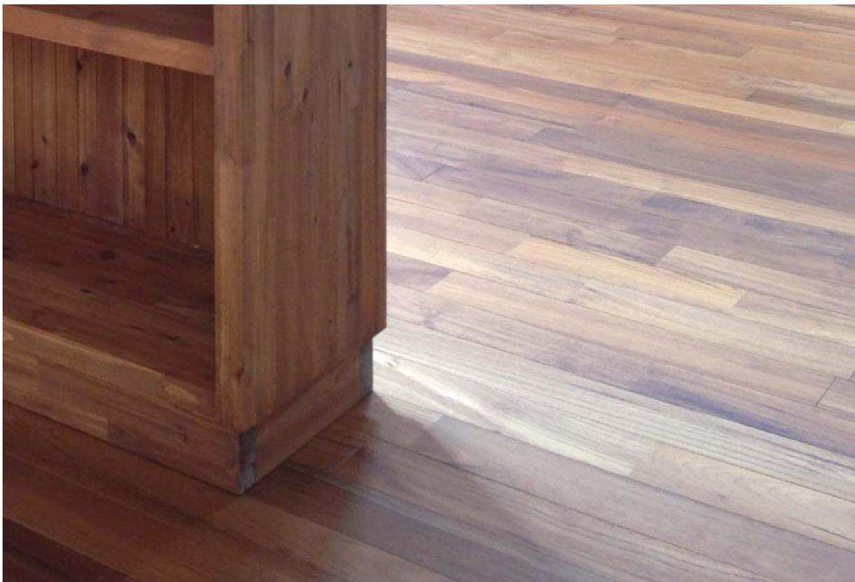
本来乱尺である商品を施工しやすいように工場であらかじめジョイントしている無垢フローリングを指します。
